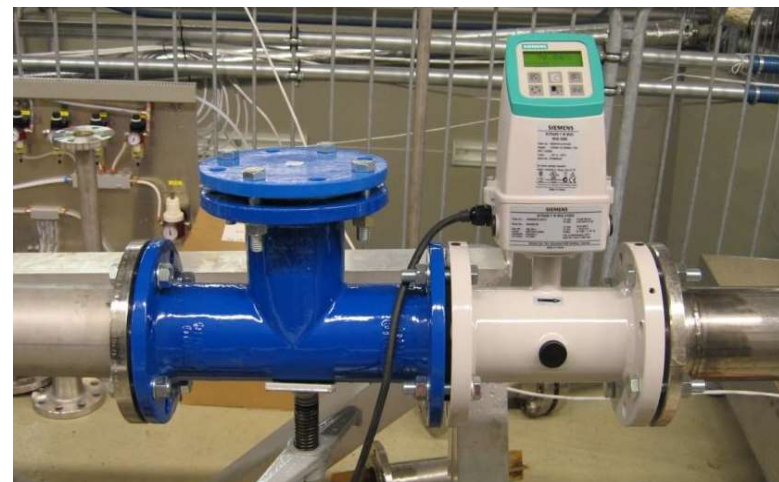
Test 3 – Måler + T-rør i rettstrekk
