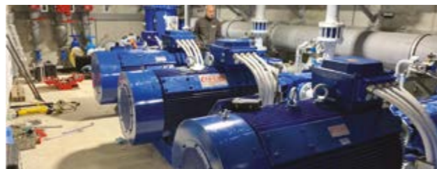
Installazione, misure di allineamento e primi avviamenti
