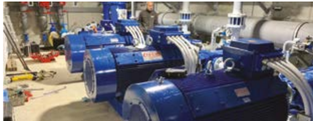
Installazione, misure di allineamento e primi avviamenti
