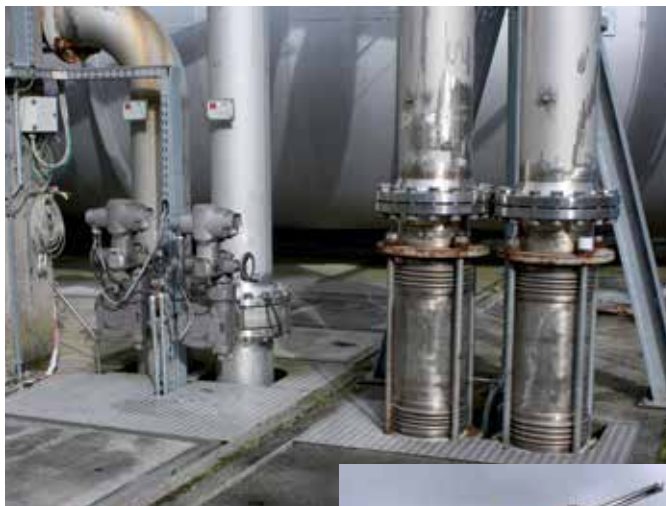
Dampferzeuger für Raketenprüfstand DLR Lampoldshausen steam generator for rocket test bench DLR Lampoldshausen
