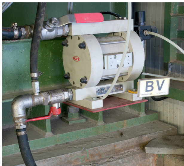
RFM: Trasporto di additivi per calcestruzzo da IBC alla torre di miscelazione.
