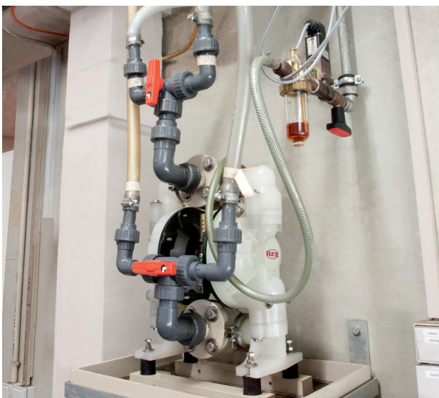
FDM: Trasporto del nichel chimico verso l'imboccatura di una vasca galvanica.
