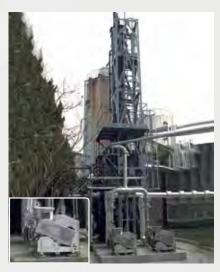
• Biogas plant: ROBOX evolution BIOGAS blower unit
