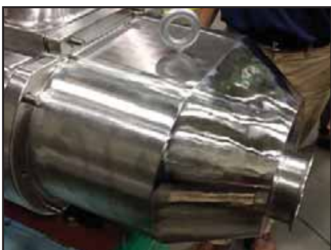
Bild 130 – Pumphöljet monterat på pumphuset
