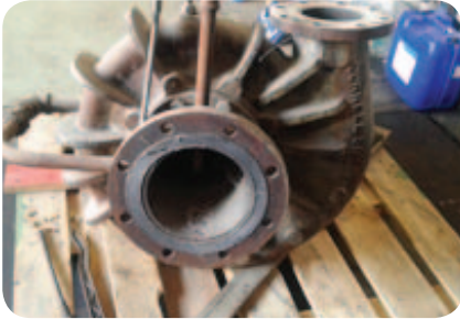
1. Демонтаж на авариралата помпа
