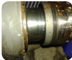
3. Отстраняване на дефектиралите механични уплътнения, O-пръстени и семеринги. Подготовка на повърхнините за монтаж на новите части.
