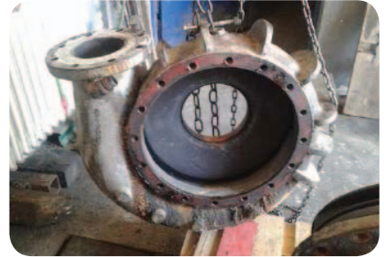
2. Разглобяване и почистване на отделните възли и детайли
