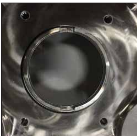
Abbildung 82 - Montierter Wellenring
