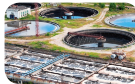
Wasser, Abwasser, Umwelttechnik
