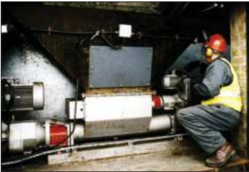
◀ In einer Abwasserreinigungsanlage wurde eine W064 Prozesspumpe zur Behandlung von Geruchsstoffen installiert. Diese Geruchsstoffe bildeten sich, weil eine Bandpresse den entwässerten Schlammkuchen direkt einer offenen Förderschnecke und einem offenen Kippkübel zur Entsorgung zuführte.
