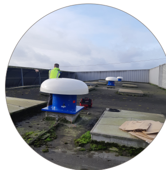
Déposes et reposes de moteurs, pompes, tourelles de ventilation entre autres
