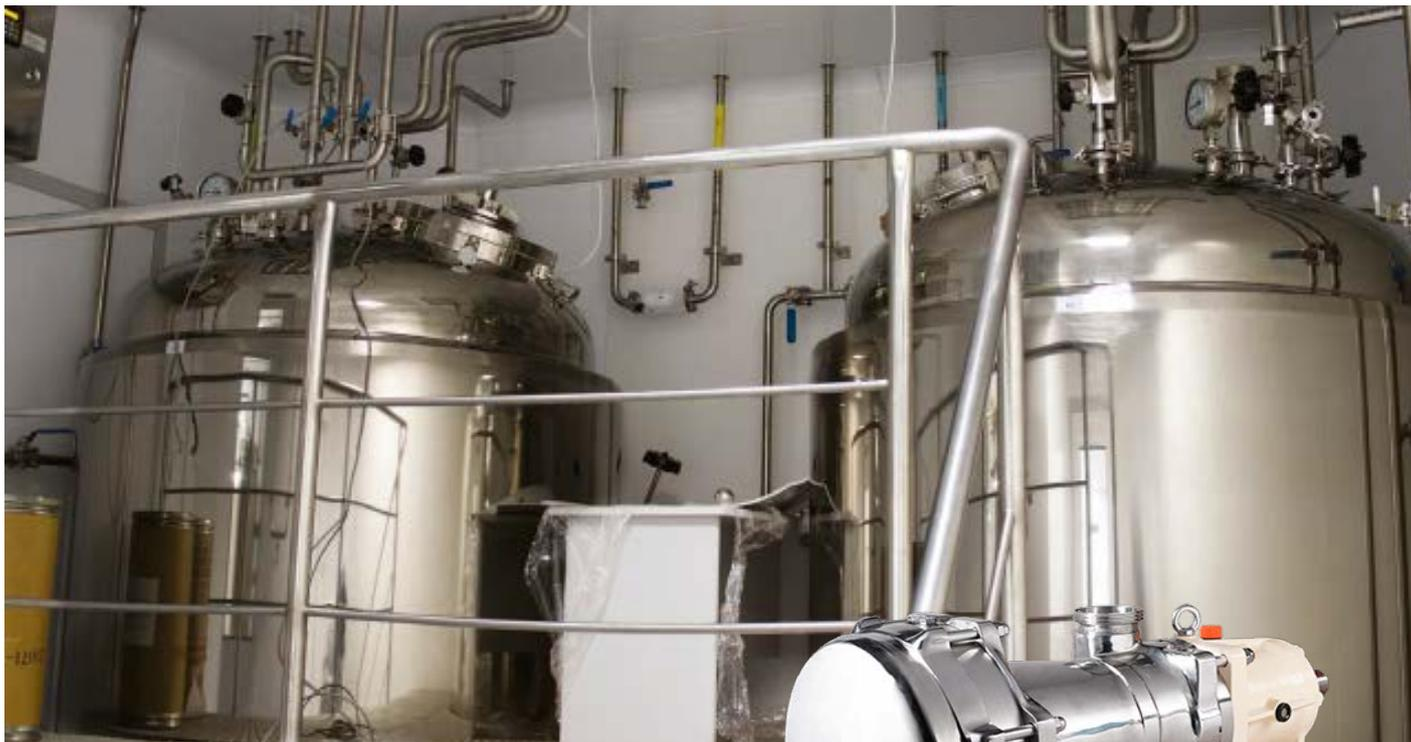
**Le pompe a disco eccentrico Mouvey® possono essere utilizzate nelle produzioni sanitarie in due modi: come una normale pompa di processo oppure come una soluzione per incrementare il recupero del prodotto. Il risultato è un minore spreco di materie prime e costosi prodotti finiti, ottimizzando quindi il processo.**
