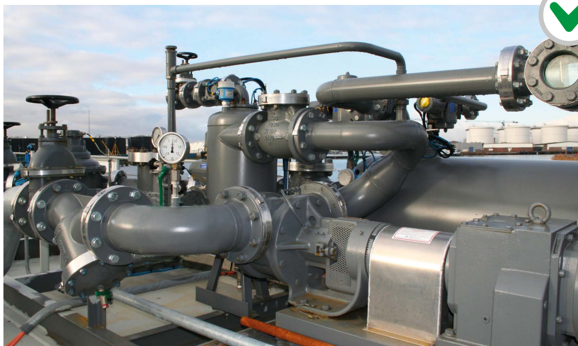
Viking Universal Seal pompunit als overslagpomp op een olietanker.
