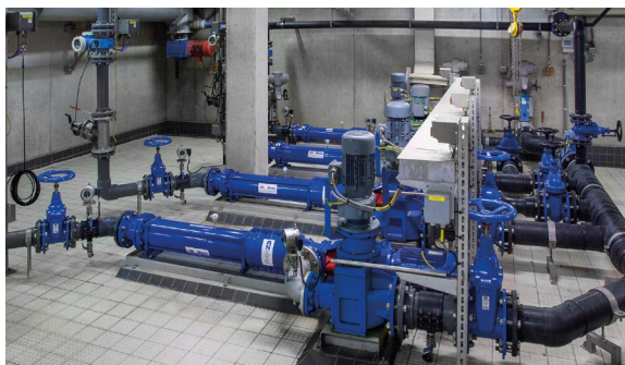
De Mono EZstrip™ Transfer pomp en Muncher in een toepassing voor mechanisch ingedikt slib (6-9% DS).
