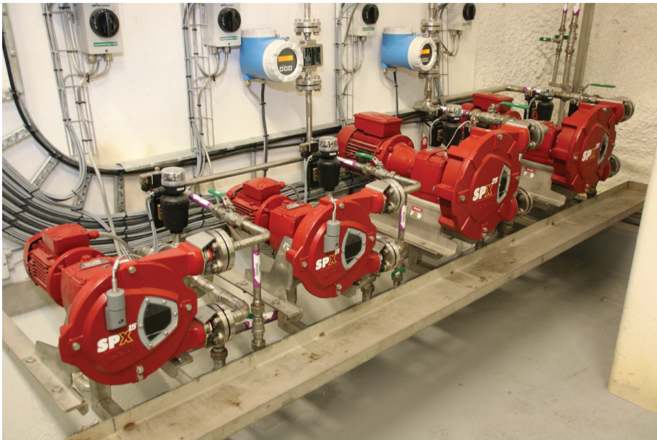
Bredel-pumper ved det nye anlegget for dosering av lut ved NRV-IKS. Installasjonen er dublet for maksimal sikkerhet og enkelt vedlikehold.
