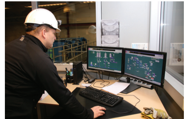
Atle Hermansen overvåker fra kontrollrom.
