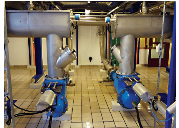
Installasjonen av to stk SK-pumper i Lillevik renseanlegg.
