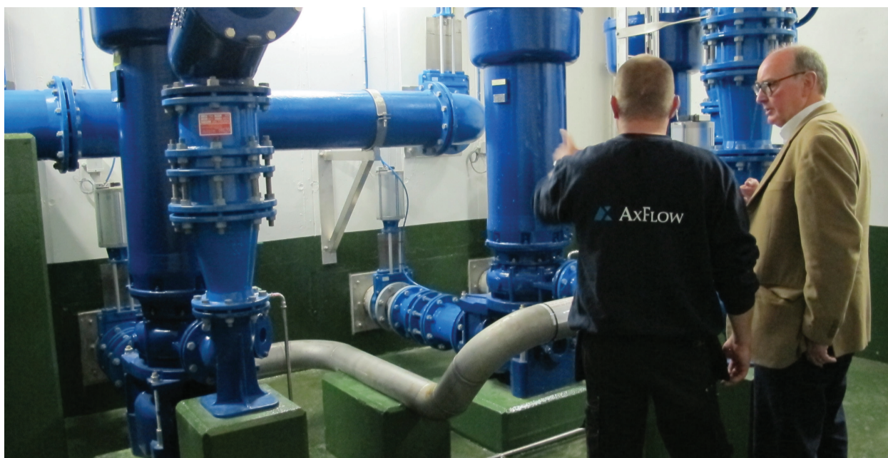
Installasjon av Hidrostat-pumper som er svært anvendelige og sørger for effektiv håndtering av væsker som kan være meget abrasive eller korrosive av natur.
