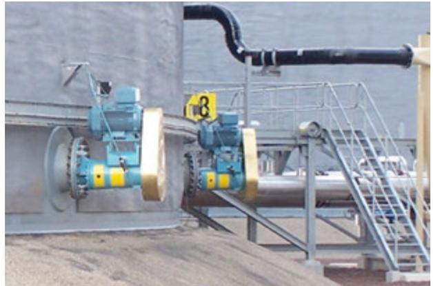
Die Horizontalrührwerke werden im Normalfall in Behälter mit großem Durchmesser eingebaut. Sie müssen in der Lage sein, einen ausreichend kräftigen Flüssigkeitsstrahl zu erzeugen, um die entgegengesetzte Wand des Behälters zu erreichen.
