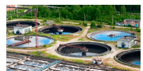
Wasser, Abwasser, Umwelttechnik
