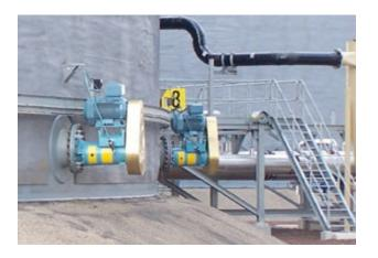
Les agitateurs horizontaux sont normalement installés dans des cuves de grand diamètre. Ils doivent être capables d'induire un jet liquide suffisamment puissant pour atteindre la paroi opposée de la cuve.
