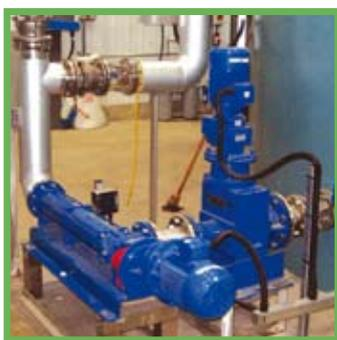
Pompe de transfert et broyeur pour déchets biodégradables
