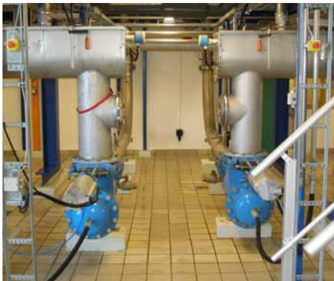
SK PUMP INSTALLATION PÅ LARVIK RENINGSVERK I NORGE
