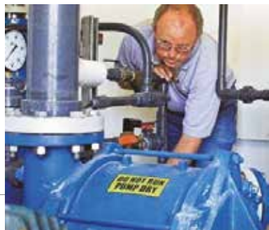
TEST AV VAKUUMPUMPAR
