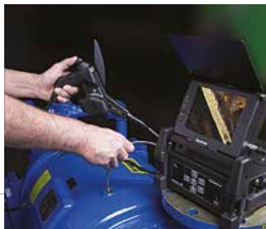
KONTROLL AV VAKUUMPUMPAR
