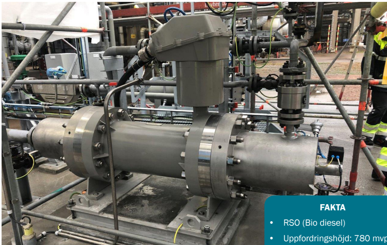
Installation av Hermetic spaltrörspump CAM för pumpning av fotogen och RSO (rapsoolja) vid produktion av förnybar diesel.
